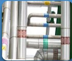
COLORAZIONE DIVERSA DEI RACCORDI E DELLE BOCCHETTE DI SISTEMI DI CARICO COME PREVISTA DELLE NORME UNI E DIN
